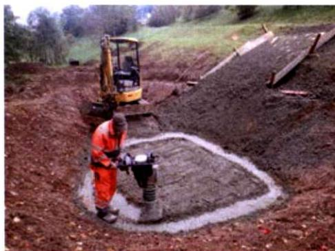
Figure 3. La marne arrive: elle est disposée sur la surface puis tassée pour assurer une étanchéité
