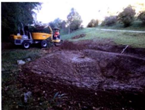
Figure 2. (gauche). Trou creusé pour la future tourbière « Léo Lesquereux ». La partie la plus basse fait 210 cm de profondeur par rapport au bord.
