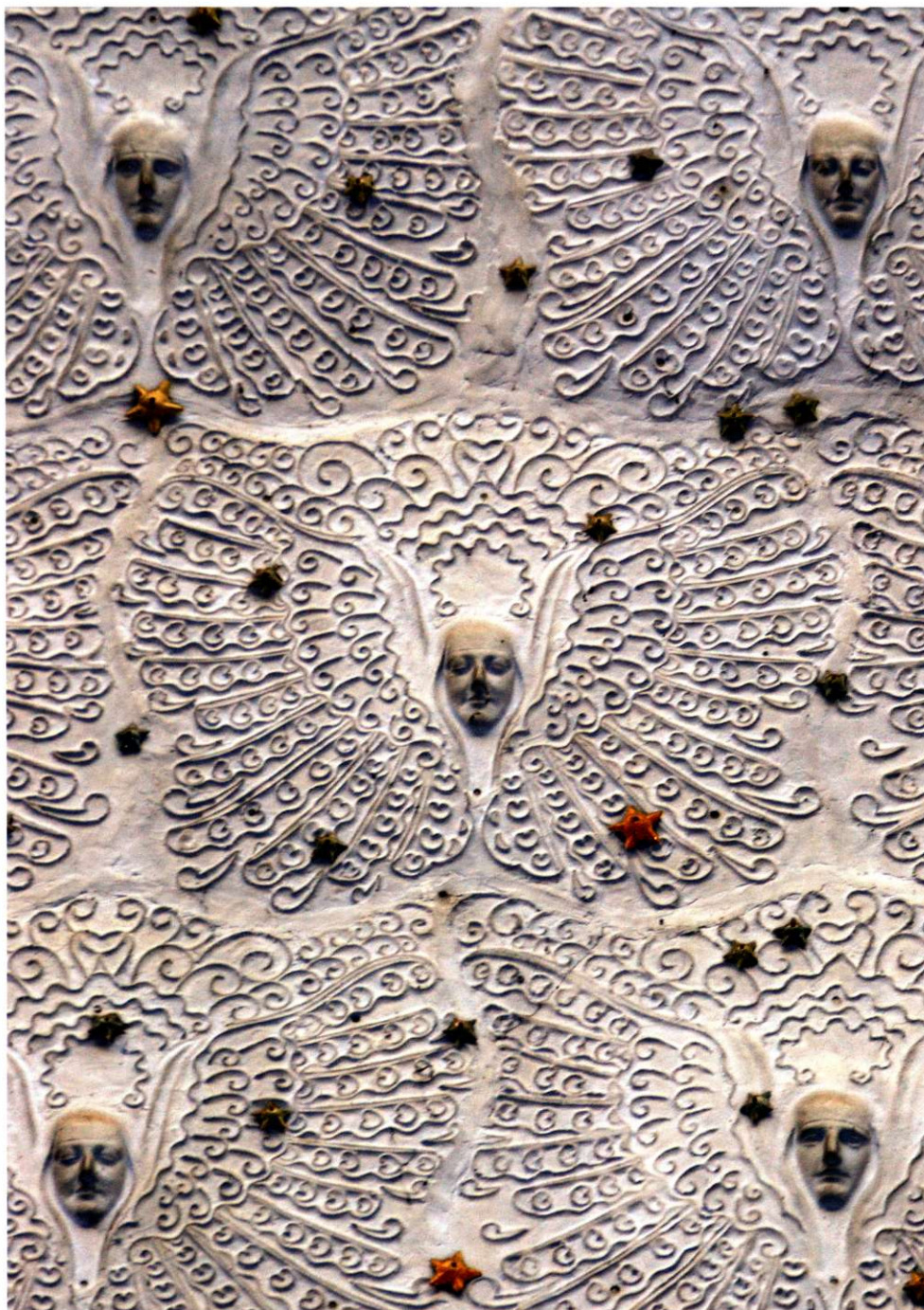
Anges en plâtre coloré recouvrant la voûte
